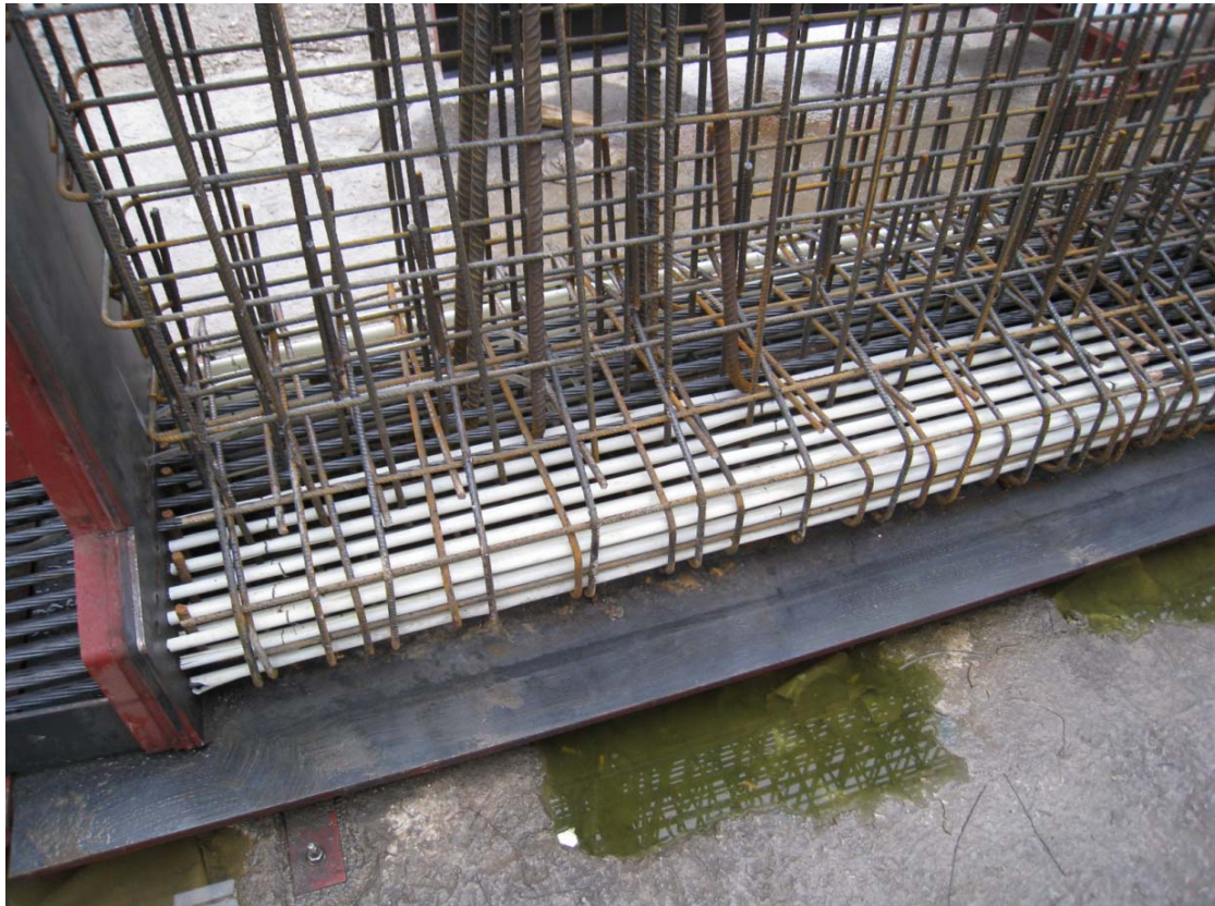
Εικόνα 2. σωλήνες απομόνωσης (διακρίνονται με λευκό χρώμα)
