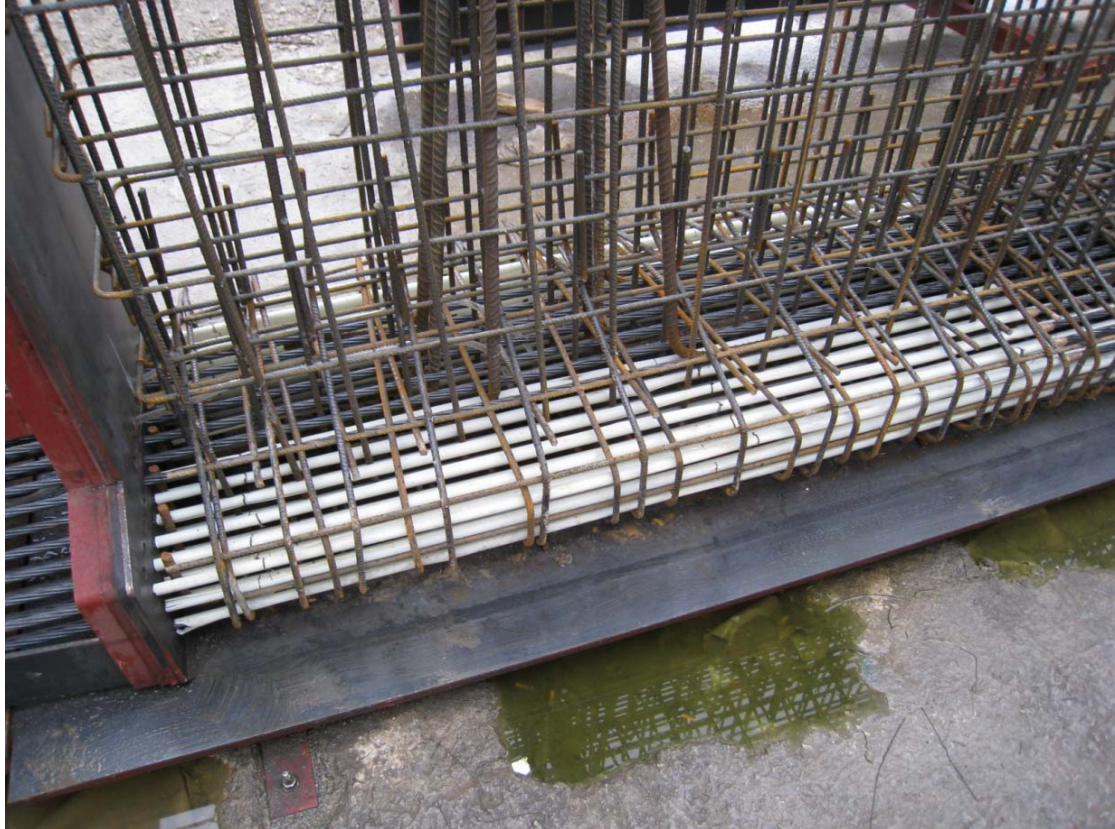
Εικόνα 2. σωλήνες απομόνωσης (διακρίνονται με λευκό χρώμα)
